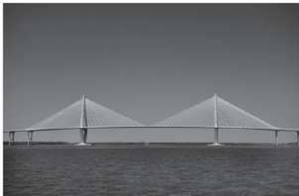
Figura 2.1.2 – Ponte estaiada (Hibbeler, 2012).
